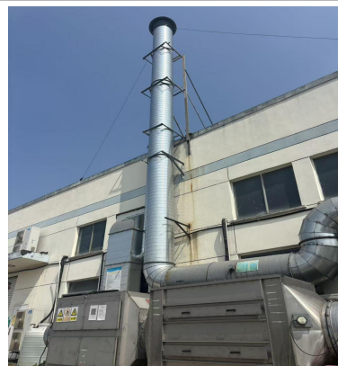
废气处理设施及排气筒照片（含采样口及标识牌）
