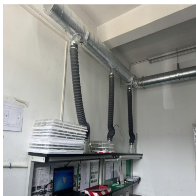
废气处理设施及排气筒照片（含采样口及标识牌）
