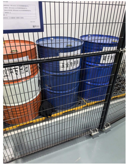
危废仓库防泄漏托盘
