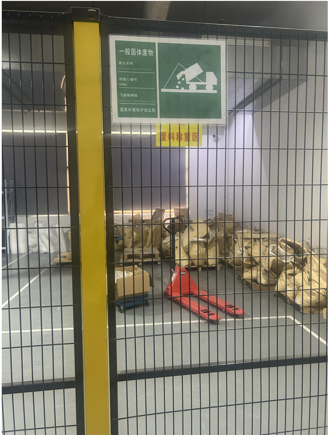
图 4.4-1 一般固废暂存区（含标识牌）
