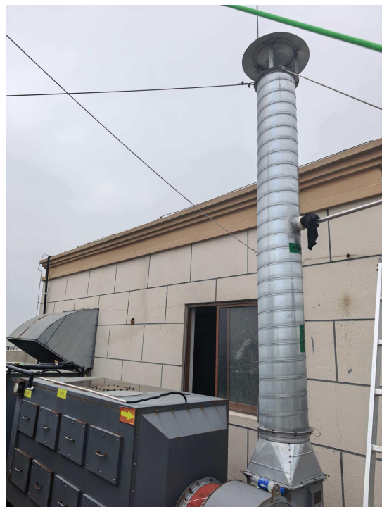
DA001 废气装置及排气筒
