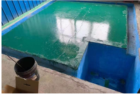
危废间内部导流槽、环氧
