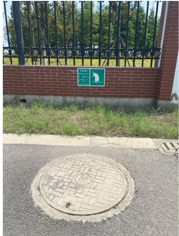
雨水排口及环保标识牌 (3)
