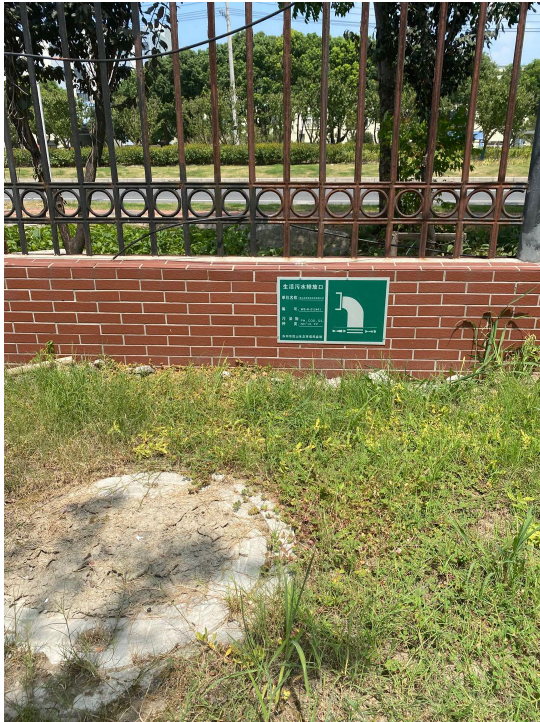
生活污水排口及环保标识牌
